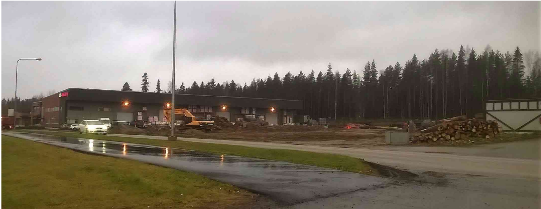
Kuva rakennustöiden alkuvaiheessa Koskelontien takaa
