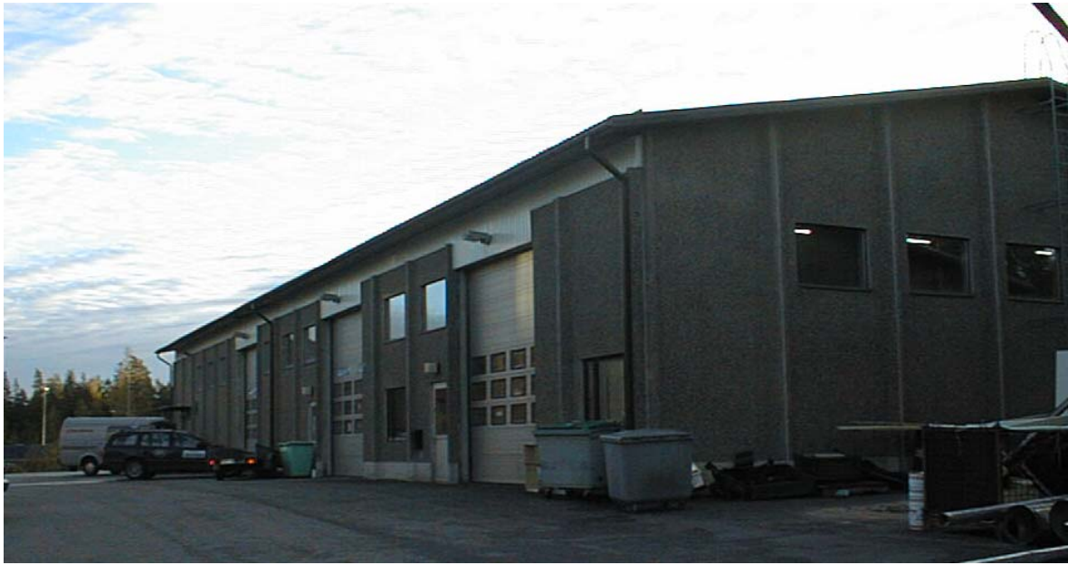
Hallitilat B1 ja B2 (julkisivu pihalta)
